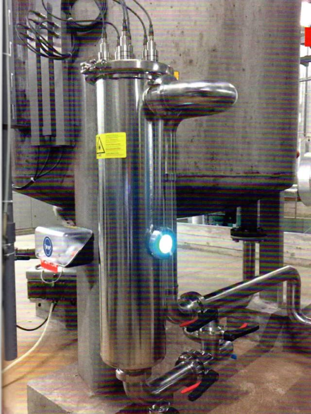
**Wasserentkeimung.** Bei dieser Lösung wird das Rückgewinnungswasser oder das reguläre Abwasser mittels einer Pumpe durch einen UV-C Reaktor geführt, dabei kontinuierlich entkeimt sowie teilweise auch entfärbt.
